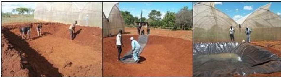
Réalisation d'un petit étang à poissons (de gauche à droite): 1) excavation et nivellement de l'étang, 2) étalement de la toile PVC et enfouissement des bords, 3) remplissage de l'étang
