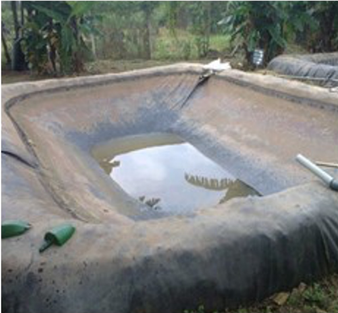
Étang creusé avec revêtement
